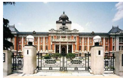
旧名古屋控訴院地方 裁判所区裁判所庁舎 (愛知県名古屋市) 【文部科学省・約1.5ha】
