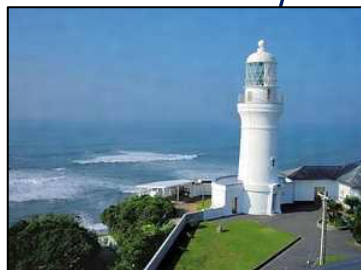
御前崎灯台 (静岡県御前崎市) 【国土交通省・約0.1ha】
