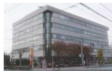
津波避難ビルに指定された沼津合同庁舎（沼津市）
