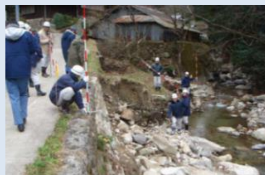
災害査定の立会
