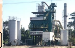
【インドネシアに建設したリサイクルアスファルトプラント】
