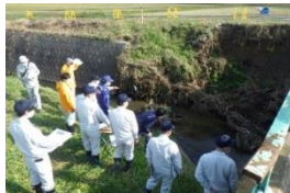
【災害査定立会の様子】 (提供：宮城県)
