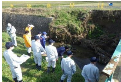
【災害査定立会の様子】 (提供：宮城県)
