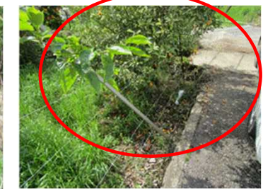
放任果樹が除去されていない箇所
