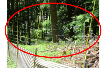
電気柵にゆがみが生じている箇所
