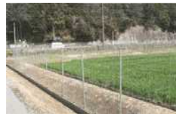
侵入防止柵の整備
