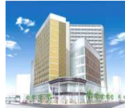
富山駅前再開発ビル(マンション、ホテルなど) (29年秋頃完成予定)
