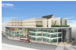
旧ラプロ跡地再開発ビル (27年9月開業予定)
