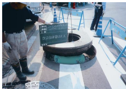
マンホール上部の撤去状況
