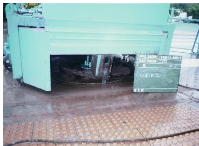
マンホール上部の切断作業
