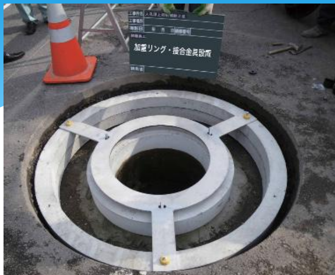
加重リング及び接合部材設置時
