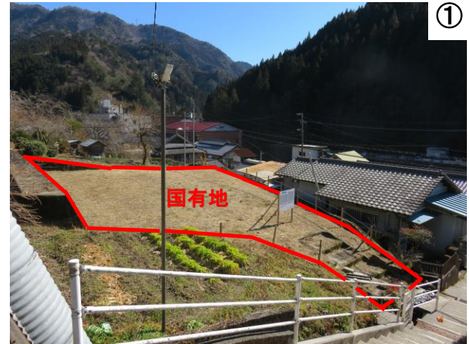
敷地及び周辺状況
