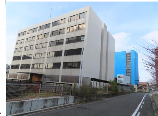
①建物南東面
