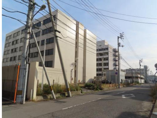
④建物北西面
