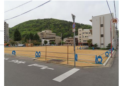
④建物北東面
