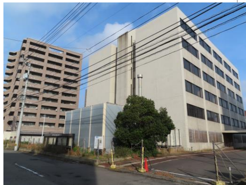
②建物南西面
