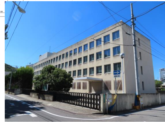
⑥参考(建物解体前)
