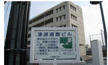
津波避難ビルに指定されている国家公務員宿舎（和歌山市・近畿財務局）
