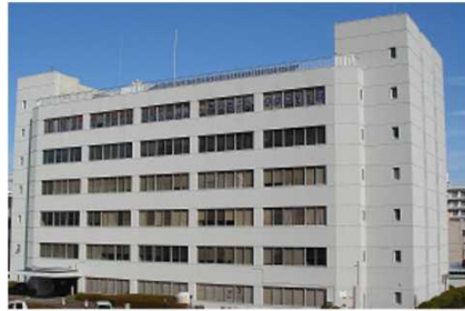
【徳島地方合同庁舎】
