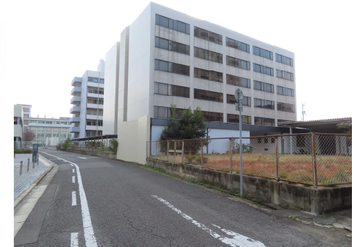
③建物北東面
