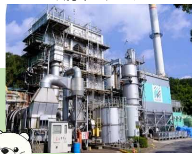
▼焼却プラント
