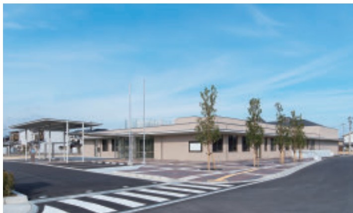
財政融資資金を活用した地域の拠点施設（香川県高松市：山田総合センター）
