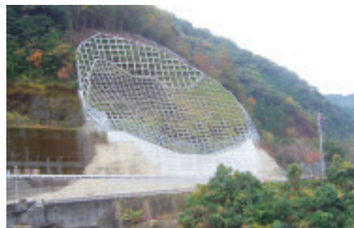
（復旧工事完了時）
