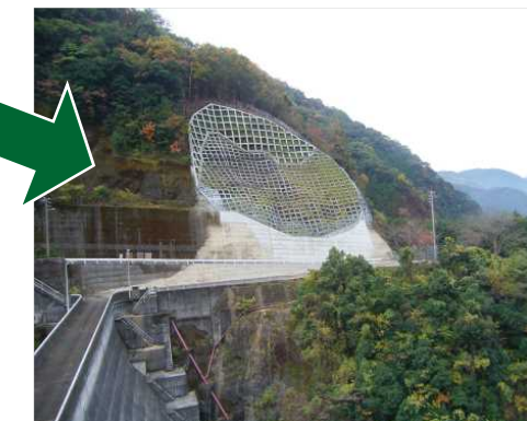
復旧工事完了時
