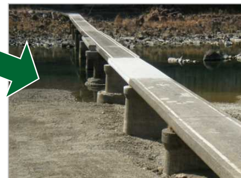
復旧工事完了時
