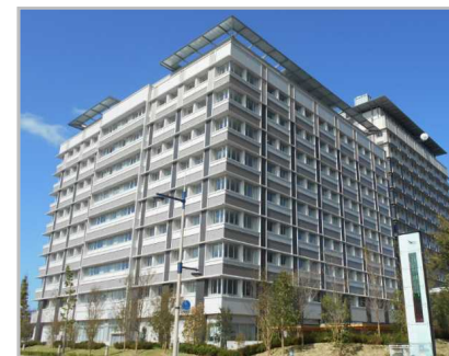
高松サポート合同庁舎
