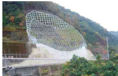
（復旧工事完了時）
