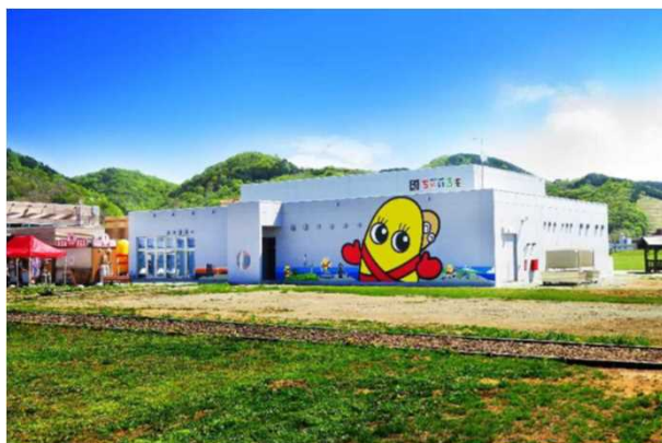
道の駅るもい整備事業(留萌市)
