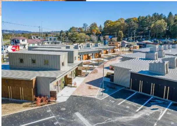
厚真町の災害公営住宅 (画像提供:厚真町)
