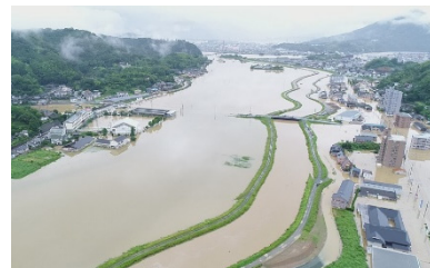
【豪雨被害の様子】
