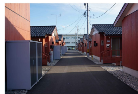
石川県輪島市の応急仮設住宅敷地
