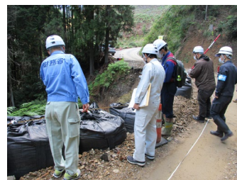
災害査定立会
