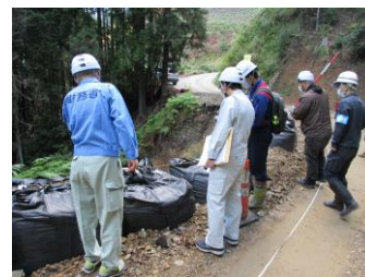
災害査定立会
