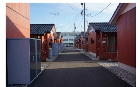
石川県輪島市の応急仮設住宅敷地
