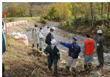
災害査定立会の様子
