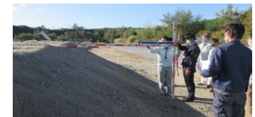
〔災害査定立会の様子〕
