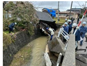
災害査定立会
