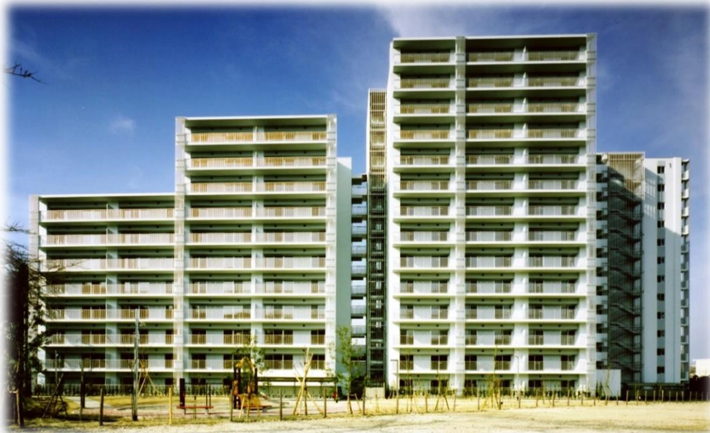
【仙台市 亀岡住宅】
