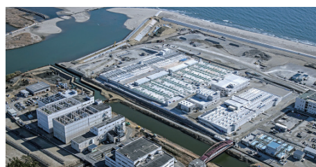
仙台市 南蒲生浄化センター （公営企業災害復旧事業債（東日本大震災分・下水道事業））
