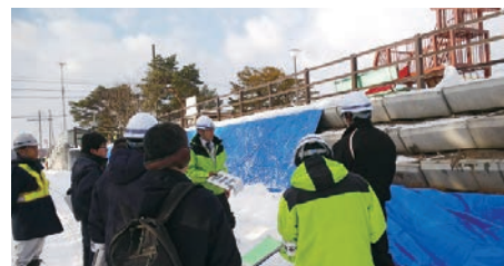
地震で被災した公園施設の災害査定立会の様子
