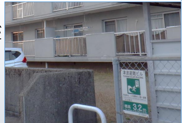
・ 津波避難ビルに指定されている国家公務員宿舎（宮崎市・潮見住宅）
