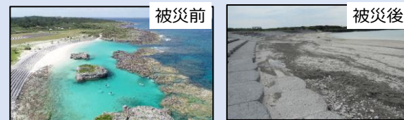
スギラビーチ被災の様子（写真提供：喜界町）
