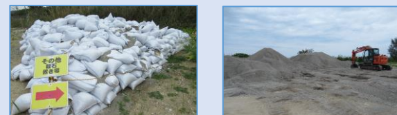
回収した軽石の作業を国有地内で行っている様子
