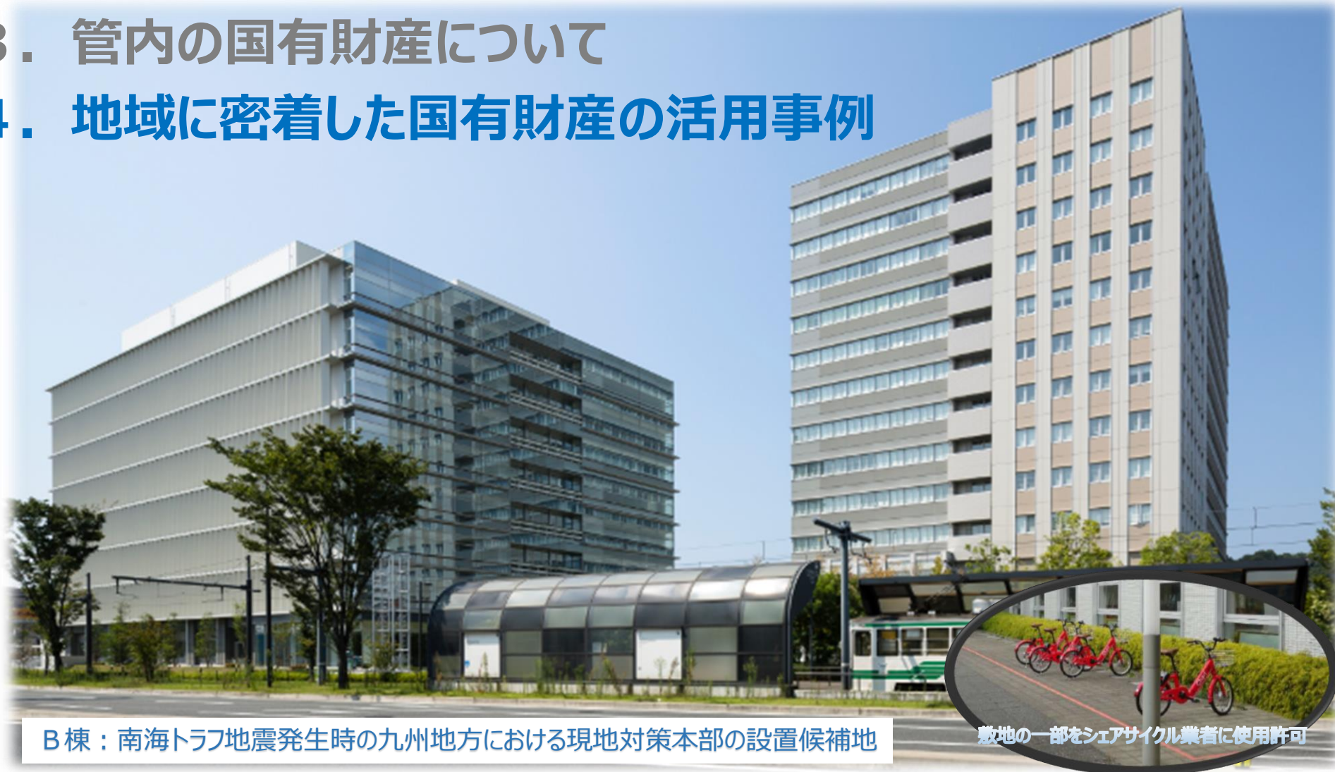
熊本地方合同庁舎 A（右）・B 棟
