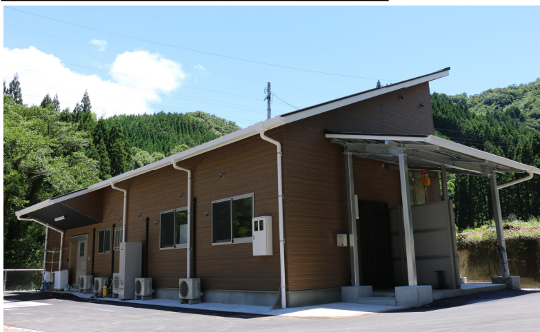
熊本県球磨村 (過疎対策事業) 「ジビエ解体処理加工施設建設事業」
