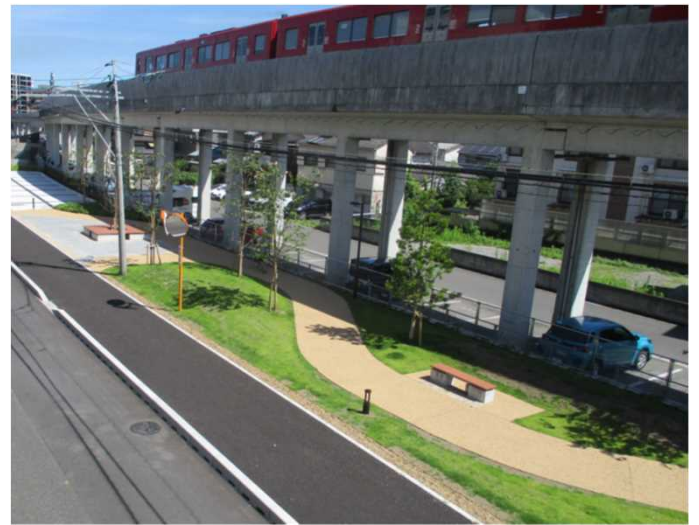
大分県大分市 (公共事業等) 「鉄道残存敷整備・活用事業」
