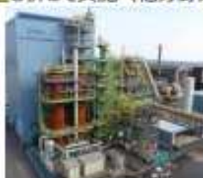
12m 3 小規模試験高炉(水素還元)
