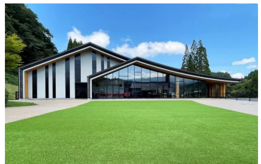
財政融資資金が活用された 「北里柴三郎記念館シアターホール」 (熊本県小国町)
