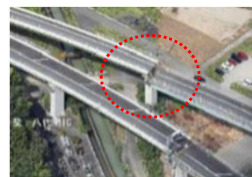
（南九州自動車道：橋梁損傷）
