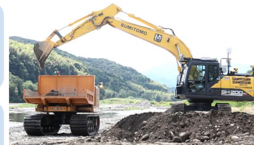
遠隔操作で進められる工事の様子(写真:旭建設)
