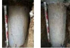
【参考】高圧噴射攪拌工法(※)による建物基礎補修(イメージ図)
