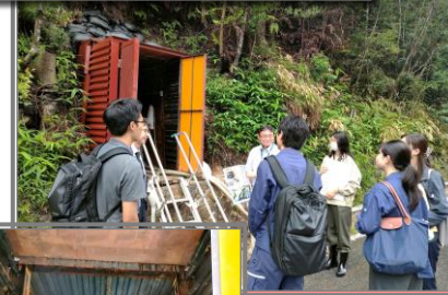
建設用地の地質調査現場
