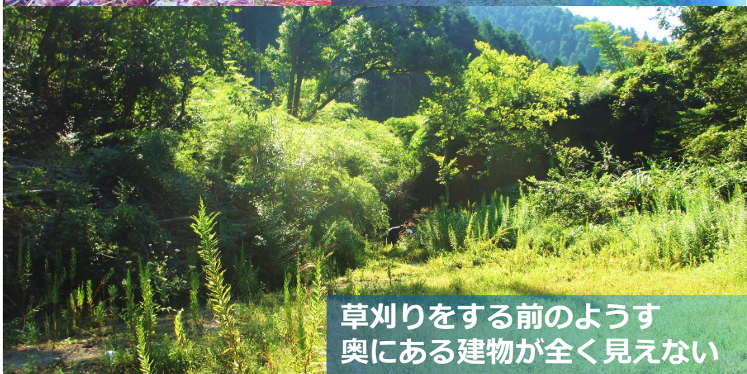
手すり設置後のようす 地下壕は急斜面の下に
