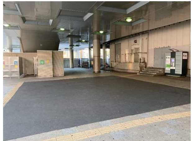
「テラス利用と一体で活用された淵野辺駅 駅下広場」
