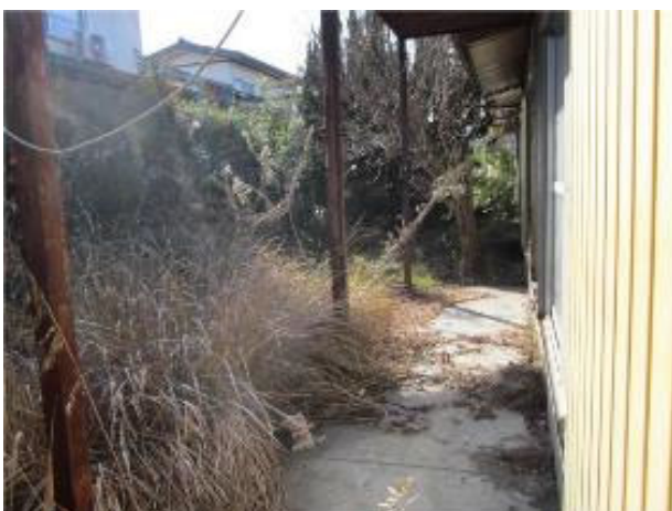
雑草が繁茂した空き家
