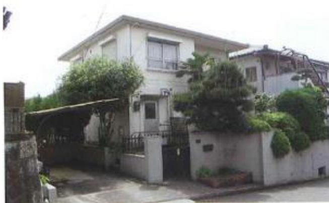
まだ使用できる空き家
