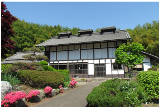
母屋兼蚕室 外観（修復工事前）
