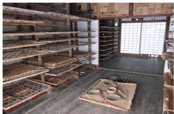
母屋兼蚕室 蚕室（修復工事前）
