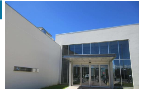
米倉山次世代エネルギーシステム 研究開発ビレッジ(当事務所撮影)
