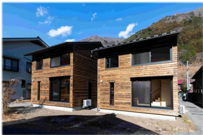
屋根には太陽光パネルを備え、環境にも配慮した仕様
