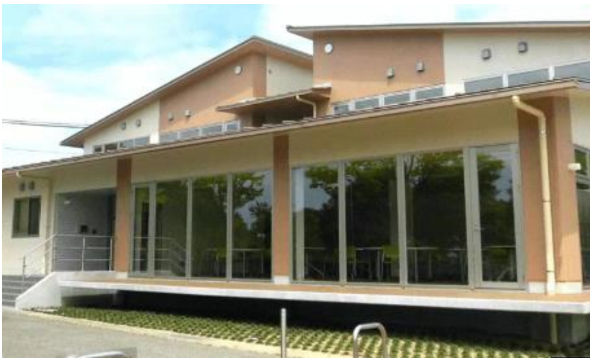
(出所) 三菱地所ポータルサイト「WORK × ation」より 和歌山県と三菱地所が整備したワーケーション施設
