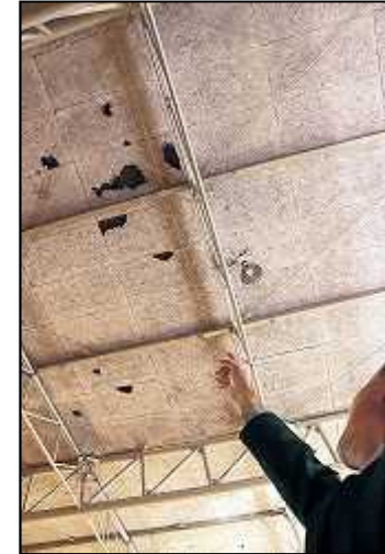
2012.12.2 笹子トンネル天井板崩落 (天井板を止めていた金属ボルト破損)
