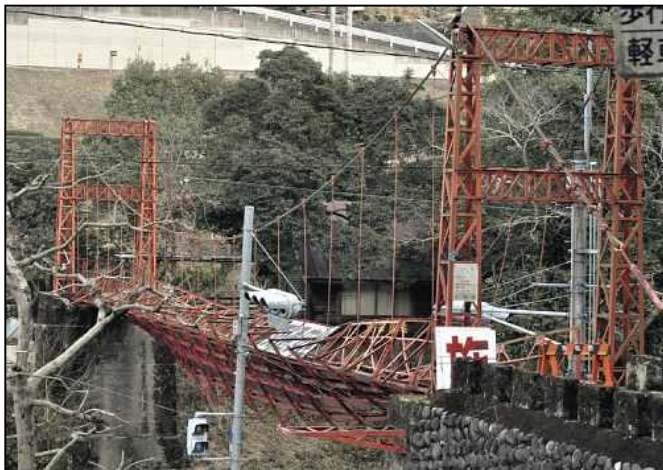
2013.2.10 浜松市第一弁天橋ワイヤ一破断事故
