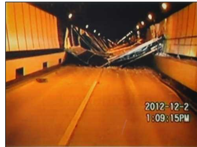
2012.12.2 笹子トンネル天井板崩落 (天井板を止めていた金属ボルト破損)
