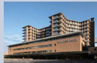
学校、病院、上下水道等を建設する場合に、必要に応じて、地方公共団体に資金を貸し付け、資金面をサポートしています。
