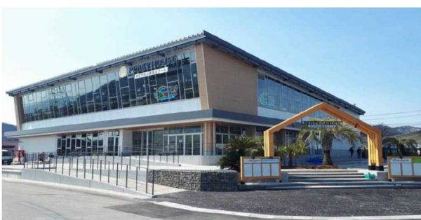
【福井県越前市】 武生中央公園温水プール (公共事業等)
