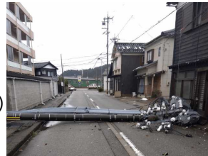
輪島宿舍敷地内の北陸電力電柱倒壊
