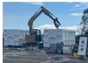
災害ごみ仮置場
