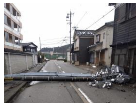
輪島宿舍敷地内の北陸電力電柱倒壊
