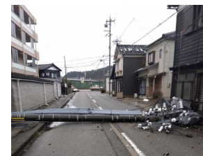
輪島宿舎敷地内の北陸電力電柱倒壊
